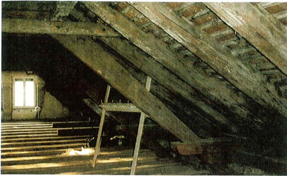
Stützenfreie Dachkonstruktion, so genannt liegender Dachstuhl.
