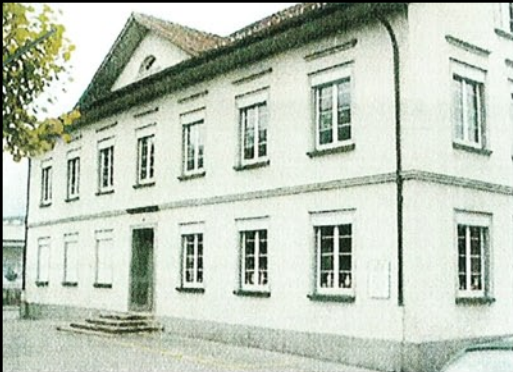
Hauptfassade vor den Renovationsarbeiten.
