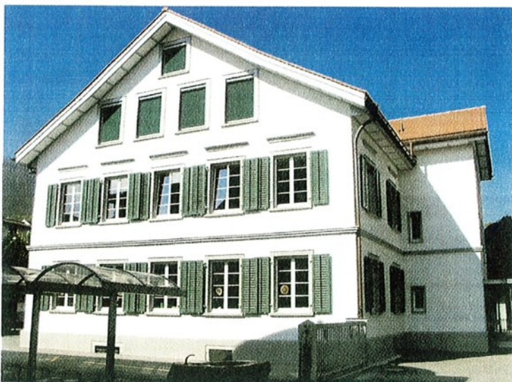
Ostfassade des Alten Schulhauses nach den Renovationsarbeiten.
