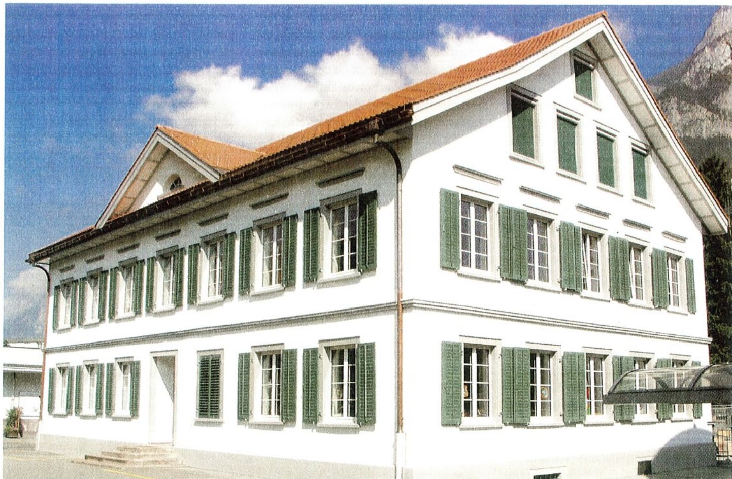
Die Hauptfassade des «Alten Schulhauses» in Mels von Südost nach den Restaurationsarbeiten 2004/2005.
